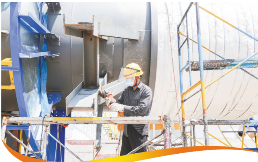
在寿光兴鲁新材料产业园项目建设现场，工人正在施工。（资料图片）
