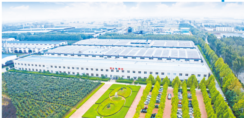
▼市金控集团控股上市公司——同大股份厂区俯瞰图。
