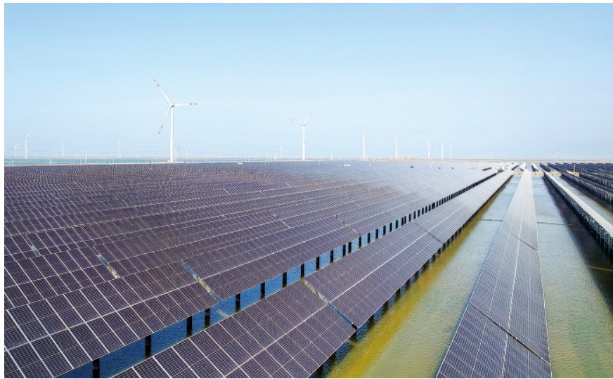
潍坊市滨海风光储能智慧能源示范基地。
