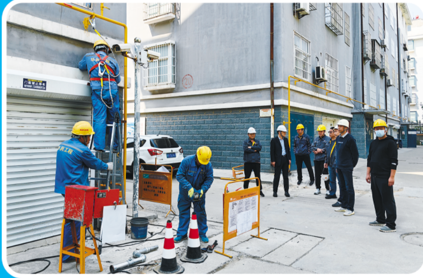
△老旧小区燃气改造现场。
