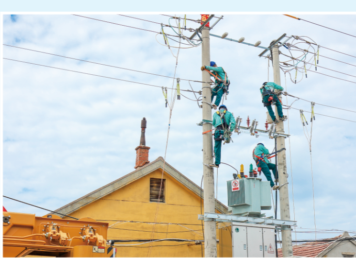
△国网潍坊供电公司员工对10千伏伏戈庄二村3号台区进行升级改造。
