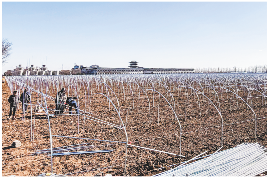
△智远生态种植农场建设现场。
