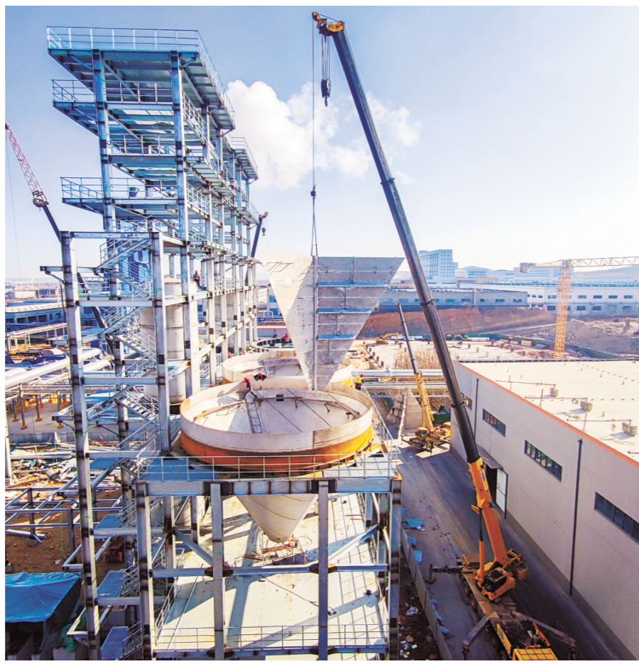
山东联科新材料有限公司年产10万吨高压电缆屏蔽料用纳米碳材料二期项目现场。
