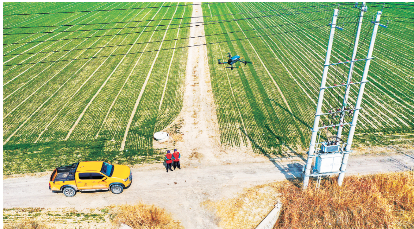
高密市供电公司使用电力定制无人机对农灌线路进行设备巡检。
