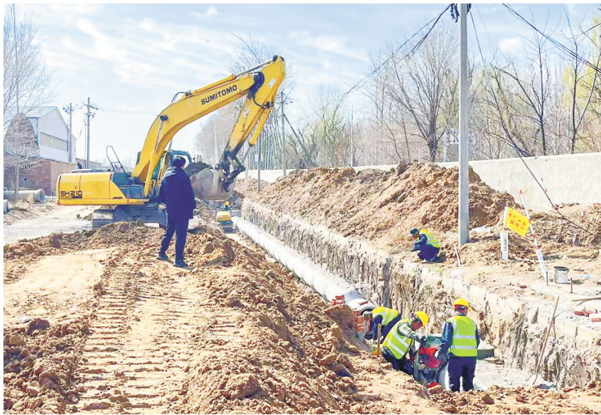
潍坊和新吴达纺织有限公司年产3000吨弹力纬纱项目建设现场。
