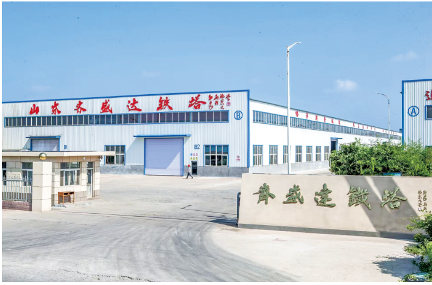
山东齐盛达铁塔股份有限公司。
