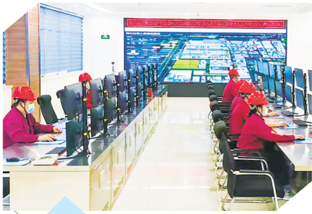
山东天力药业有限公司山梨醇车间氢化岗位工作人员精准监控设备运行。
