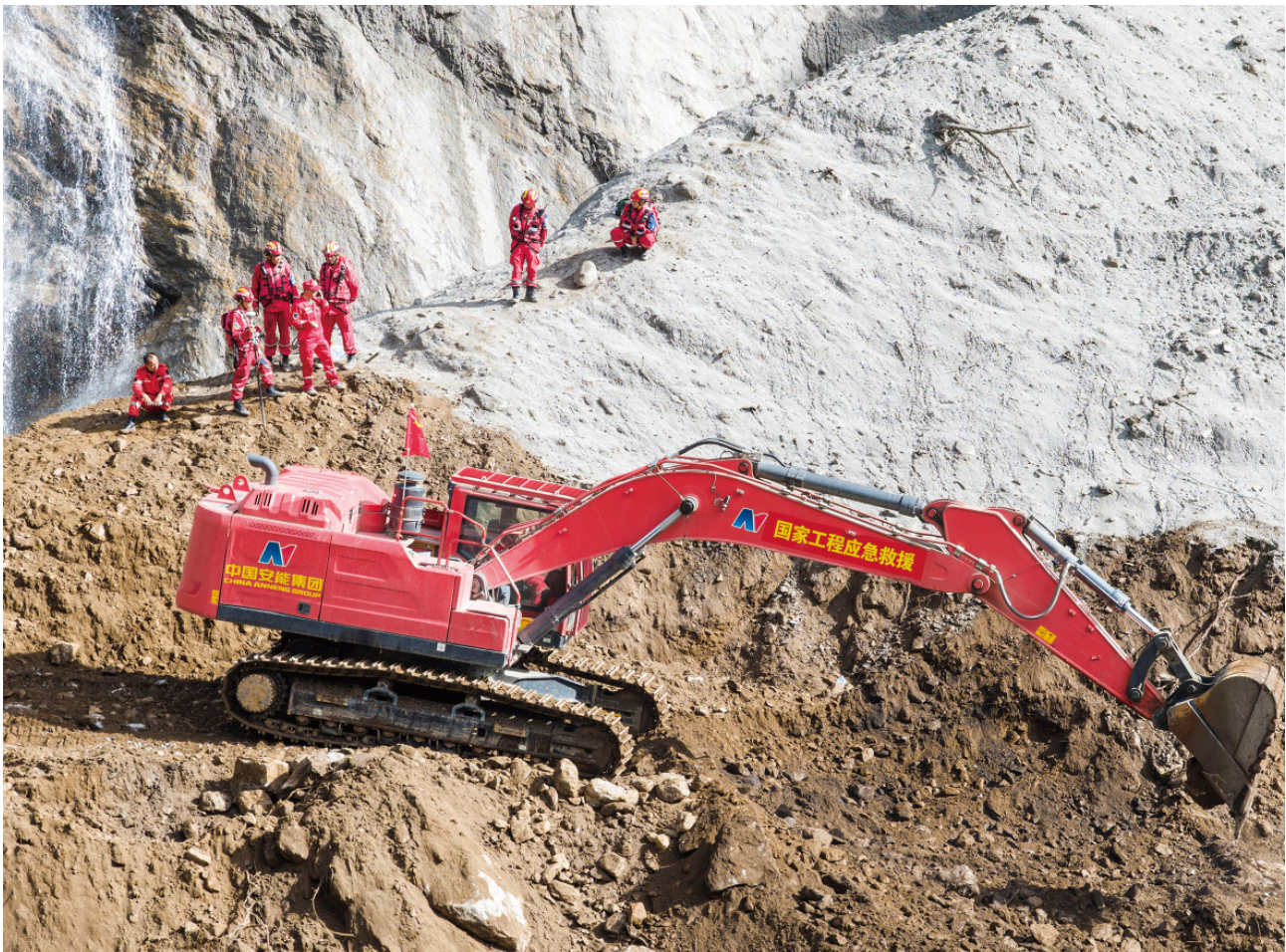
这是9月1日拍摄的道路抢通现场（无人机照片）。当日18时许，G216线受吉隆泥石流灾害冲毁的道路已抢通至距离吉隆口岸岸剩余700米。（新华社发）
